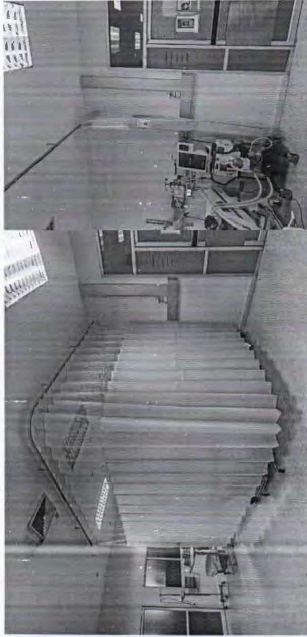
ความห่างของขา suspended อยู่ที่ 60 cm เพื่อความแข็งแรงของรางมาก
